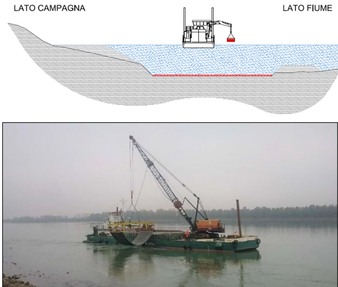
Figura 4 – Immagine di varo di teli filtranti zavorrati mediante apposita gru con telaio di varo
